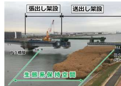
図-4 送出し架設等の施工状況
