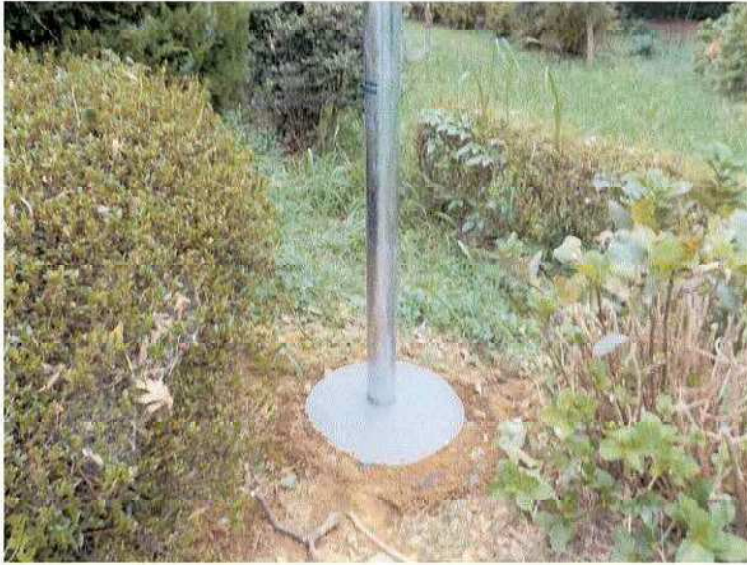
中間柱 建柱基礎 根巻き生コン 完成状況
