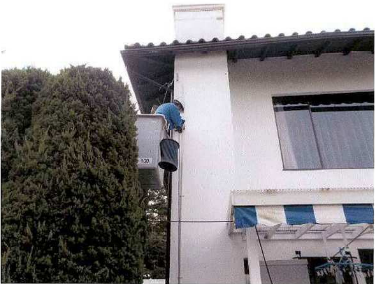
引込口 配線状況
