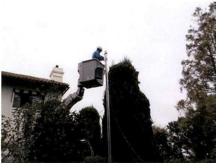
中間柱 ～引込柱 配線状況
