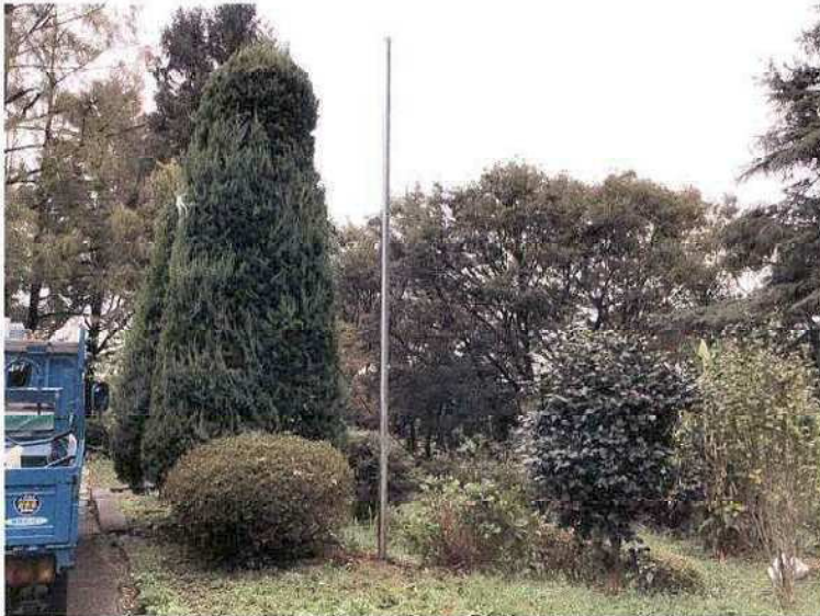
中間柱 建柱 完成状況
