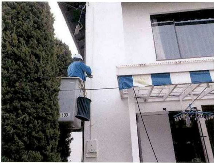
引込口 配線状況
