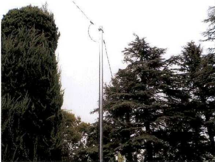
完了状況 中間柱 ～引込柱配線
