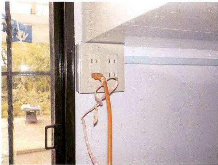
宅内 コンセント設置 完成状況
