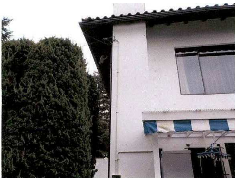
引込口 完成状況
