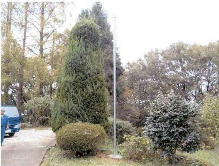
完了状況 中間柱 ～引込柱配線
