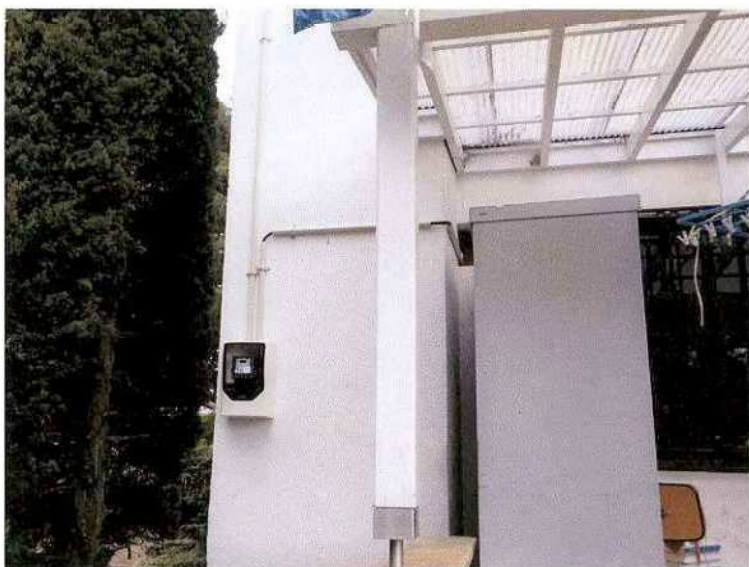
引込口 完成状況
