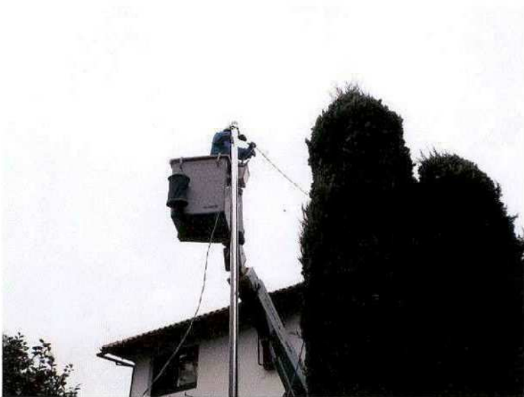
中間柱 ～引込柱 配線状況
