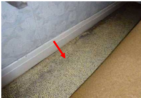
【2F 寝室A】 確認できる範囲に劣化は見られない
