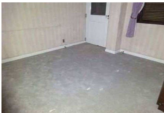
【2F 寝室C】 カーペット下に使用されている
