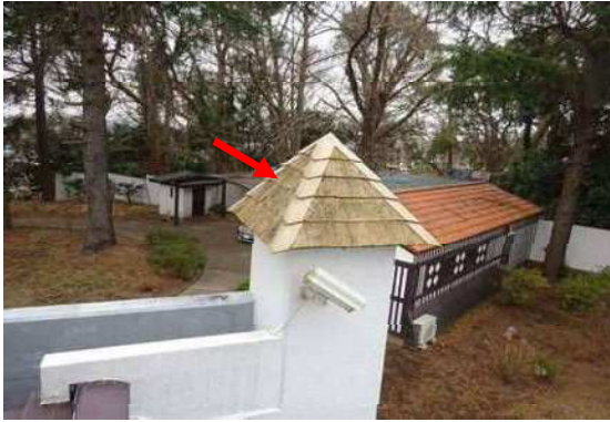
【 RF 外部(増築部) 】遠景 劣化は見られない
