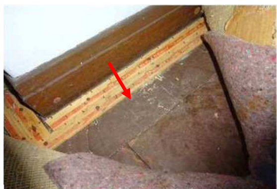
【 1F 居間 】 確認できる範囲に劣化は見られない
