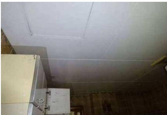
【 2F 浴室① 】 劣化は見られない
