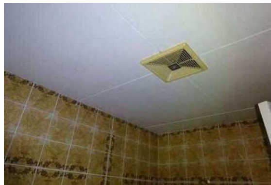
【 2F 浴室① 】 劣化は見られない
