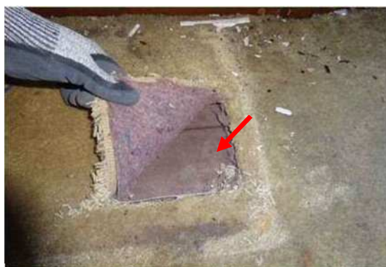
【1F 書斎】 確認できる範囲に劣化は見られない
