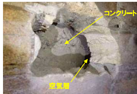
1F 書斎 暖炉内部 耐火レンガ裏確認状況
