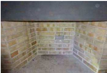
1F 居間 暖炉内部
