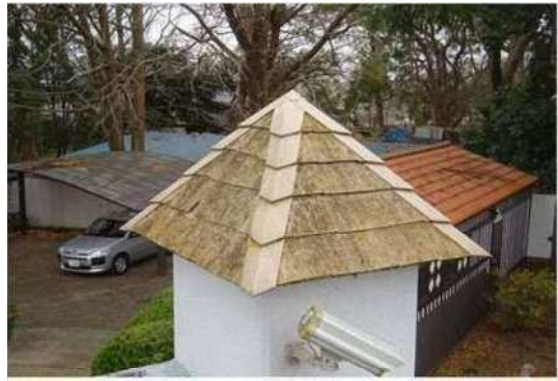
【 RF 外部(増築部) 】 劣化は見られない
