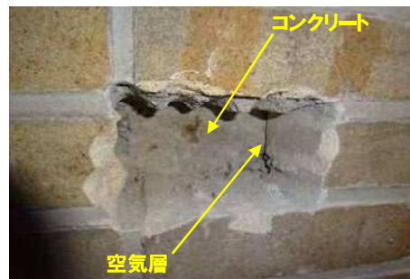
1F 居間 暖炉内部 耐火レンガ裏確認状況
