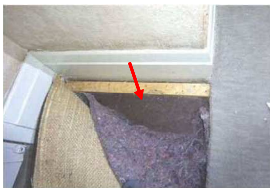
【2F 寝室C】 確認できる範囲に劣化は見られない
