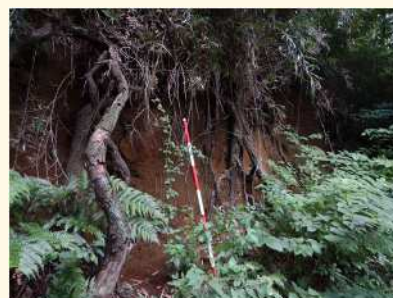
専門家による斜面調査
