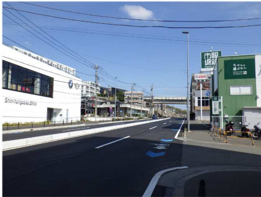
整備後(車道4車線及び中央分離帯)
