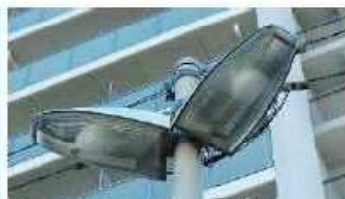
方式② ポール設置 (2基)
