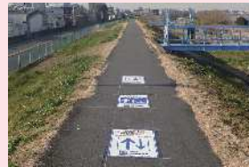
設置した路面標示
