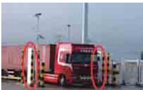
据置型放射線検知施設
