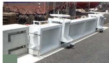
海岸保全施設の改良
