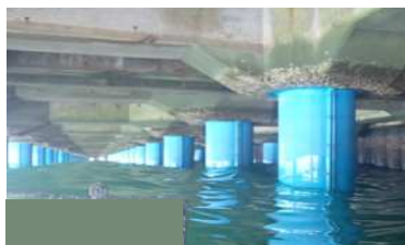
係留施設等の延命化
