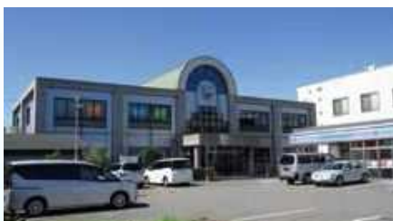
東扇島福利厚生センター(マリンプラザ) (食堂、売店、診療所、理容室、休憩室、事務室) Higashi-Ohgishima Welfare Center (cafeteria, shops, clinic, barber shops, breakroom, office) 东扇岛福利厚生中心(食堂、小卖部、诊所、理容室、休息室、办公室)
