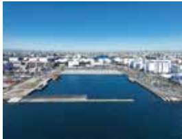
東扇島堀込部（令和8年1月撮影） Excavated part of Higashi-Ogishima (Photo taken in Jan. 2026) 东扇岛堀込部（摄于 2026 年 1 月）
