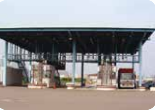
出口ゲート Exit gate
