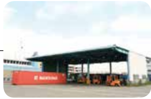
全天候型検査場 All-weather inspection Areas
