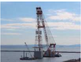
ケーソン据付工事 Caisson installation work 沉箱の安装施工
