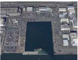
東扇島堀込部 (令和4年12月撮影) Excavated part of Higashi-Ogishima (Photo taken in Dec. 2022) 东扇岛堀込部 (摄于 2022 年 12 月)
