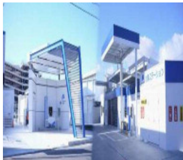
水素ステーション
