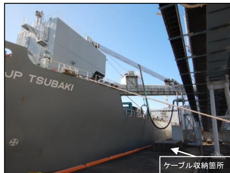
陸電供給実施状況
