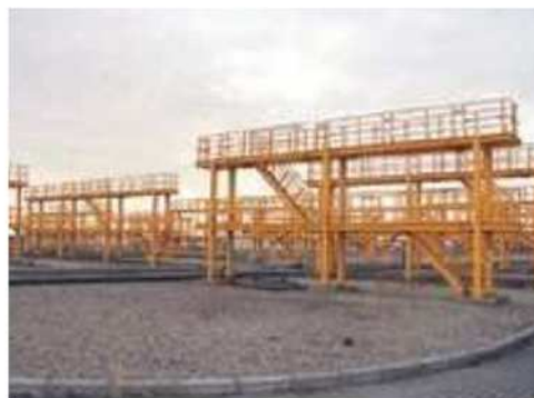
図 コンテナターミナルのリーファー電源
