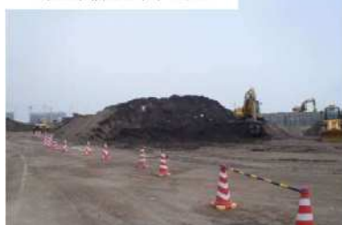
津波堆積土砂仮置状況
