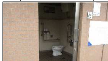
写真 多目的トイレの設置例 (設置場所：東扇島西公園)
