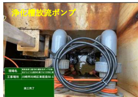
東扇島東公園 3 浄化槽放流ポンプ交換及びちどり公園浄化槽ブロワ交換工事
