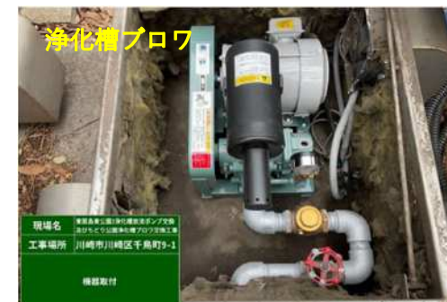
東扇島東公園 3 浄化槽放流ポンプ交換及びちどり公園浄化槽ブロワ交換工事
