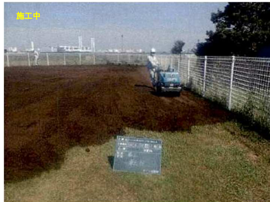
わんわん広場小型犬エリア客土敷設工事
