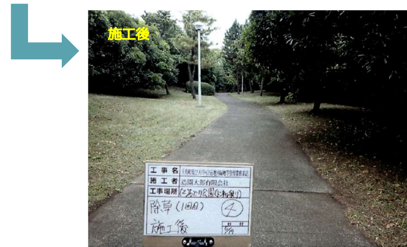
中公園外灯電源線補修工事
