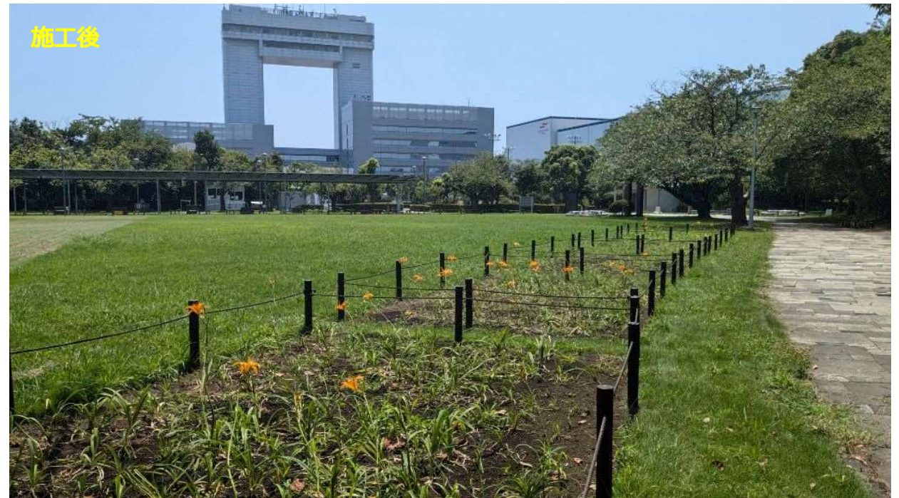
東扇島中公園花壇新設工事
