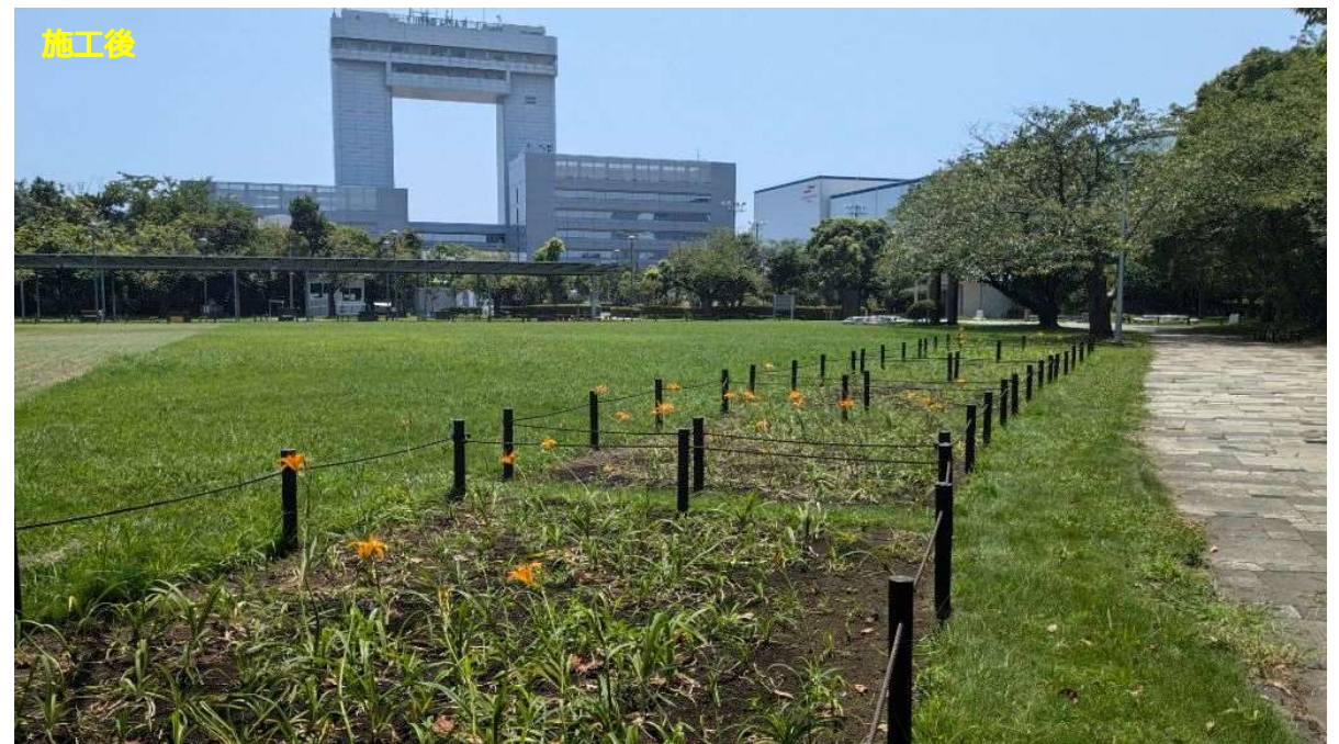
東扇島中公園花壇新設工事
