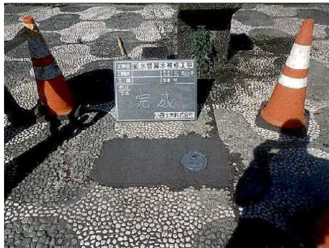
大川町緑地給水管漏水補修工事
