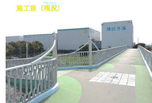
スキップウォーク通行部改良工事
