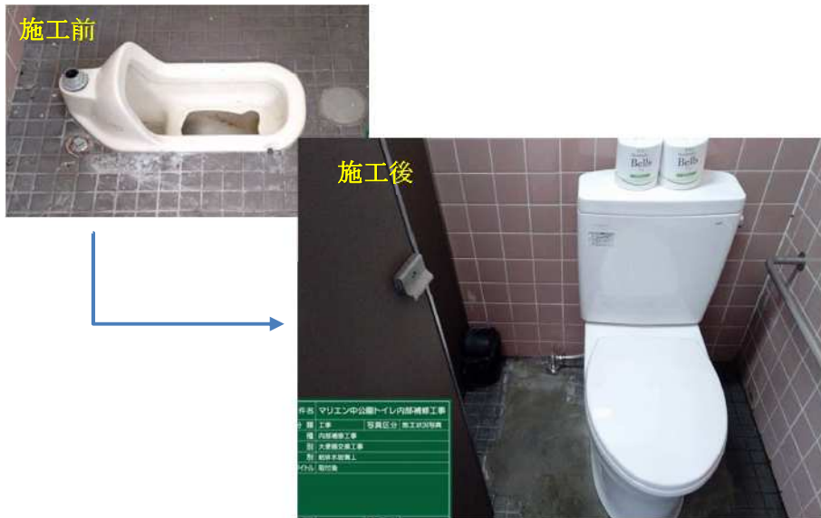
マリエン中公園トイレ内部補修工事
