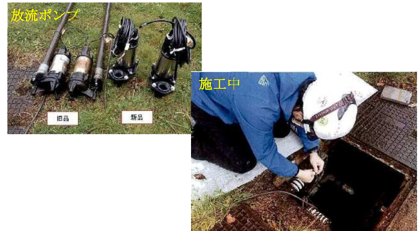
東扇島西公園トイレ2浄化槽放流ポンプ交換
