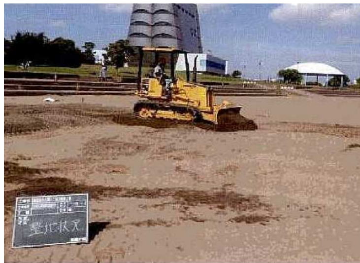
東扇島東公園人工海浜補修工事
