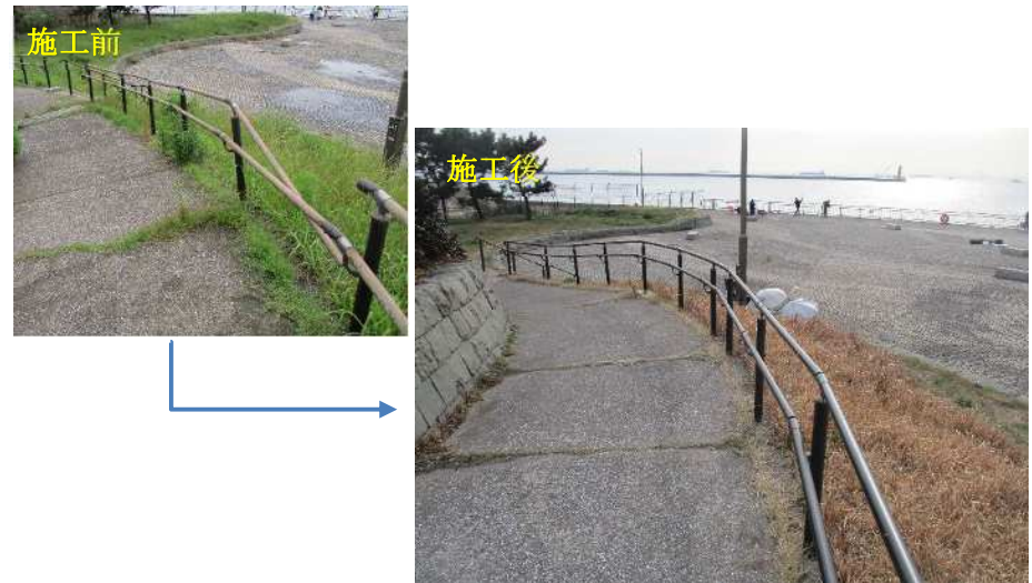
東扇島西公園施設補修工事
