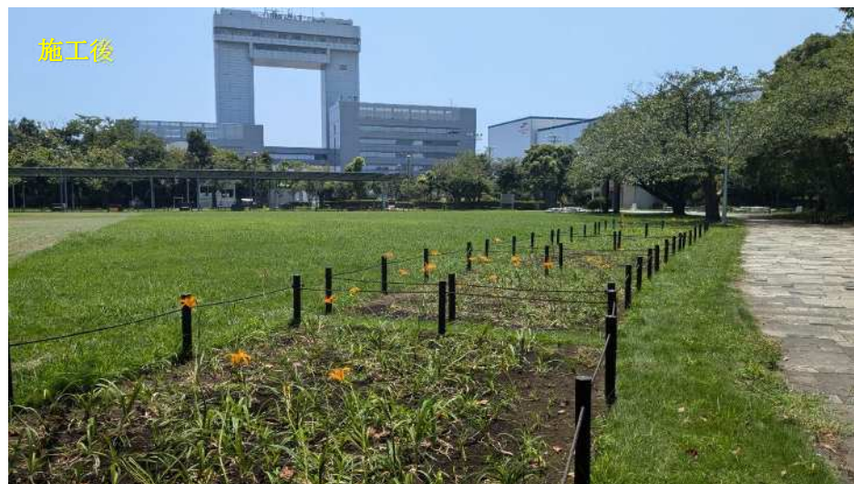
東扇島中公園花壇新設工事
