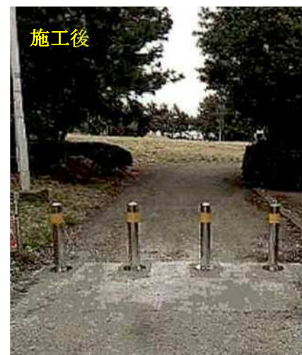
千鳥町公園バリカー補修工事
