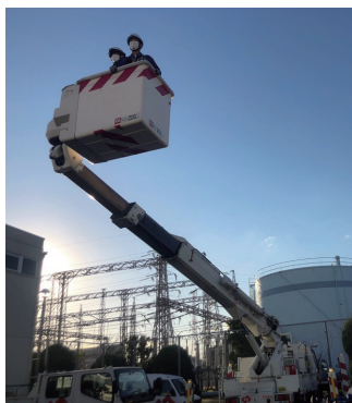
高所作業車での設備保守作業を体感
