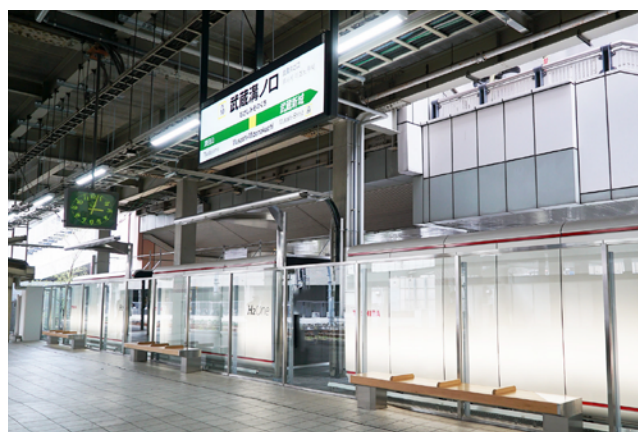
JR 南武線 武蔵溝ノ口駅 上りホーム
