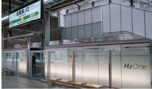
鉄道駅へのCO2フリー水素エネルギーの導入（JR南武線 武蔵溝ノ口駅）
