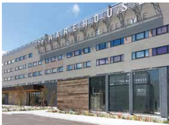
川崎キングスカイフロント東急REIホテル （水素を燃料電池で利用）
