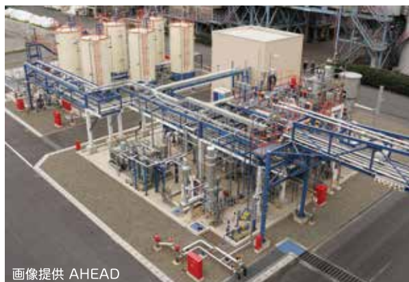
東亜石油京浜製油所内にある脱水素プラント
