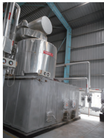
バイオマス燃料ボイラーの活用によるCO 2 排出量削減
