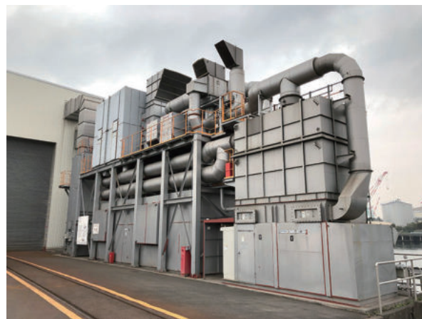
除去装置導入による揮発性有機化合物 (VOC) の排出抑制 (京浜事業所)
