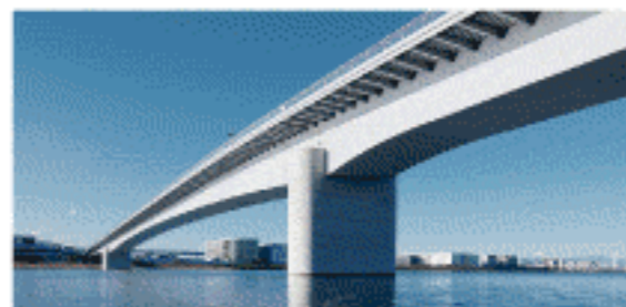
多摩川スカイブリッジ
