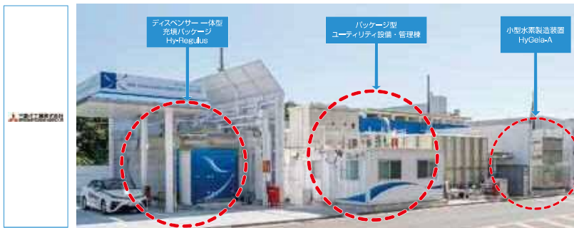
MCK 川崎水素ステーション
