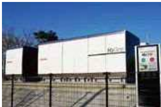
再生可能エネルギーと水素を用いた自立型水素エネルギー供給システム(川崎マリエン)
