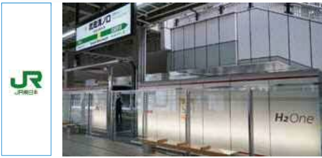
鉄道駅へのCO 2 フリー水素エネルギーの導入（JR南武線 武蔵溝ノ口駅）
