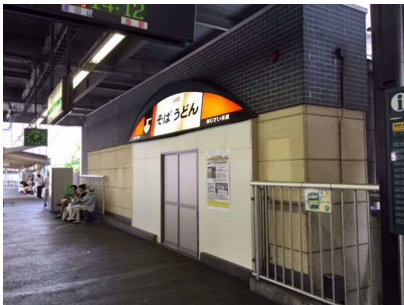
ホーム整備前
