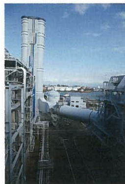
JERA 川崎火力発電所
