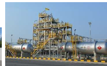
ブルネイ国側 水素化プラント
