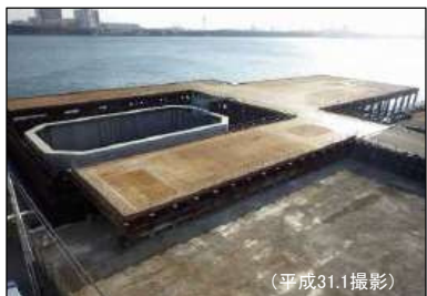
② 橋脚MP4 (平成30.12施工完了) ニューマチックソリ基礎完成
