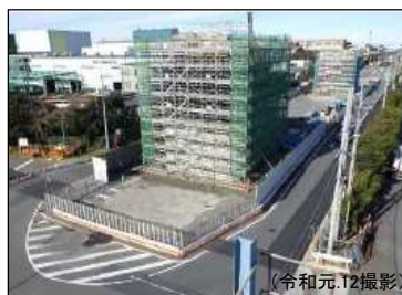
③ 橋脚MP5,6 橋脚部構築状況
