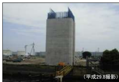
① 橋脚MP1 (平成29.8施工完了) 橋脚下部完成
