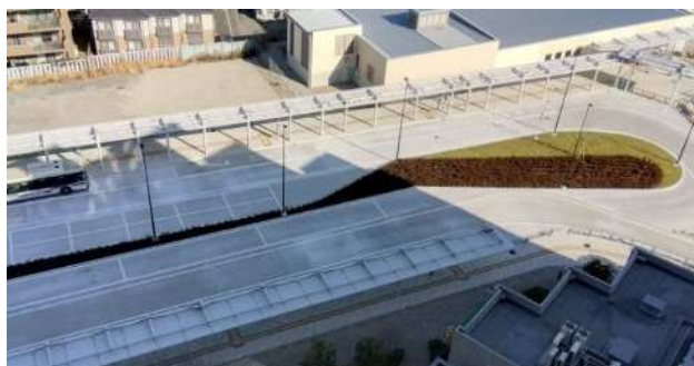
図 大師橋駅前交通広場(俯瞰)
