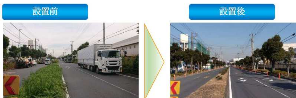
図 大型車の路上駐停車抑制対策（ラバーポール）の設置効果
