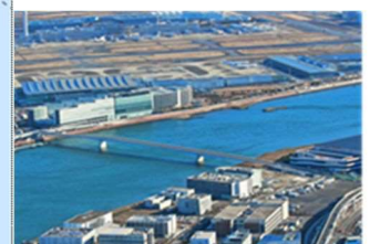
多摩川スカイブリッジ
