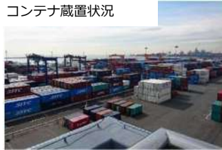
コンテナ蔵置状況
