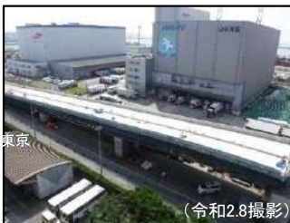
① 東扇島AP部1工区 (令和2.9施工完了) 上部工完成
