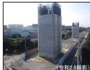
③ 橋脚MP5.6 (令和2.9施工完了) 橋脚下部完成
