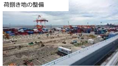
荷捌き地の整備
