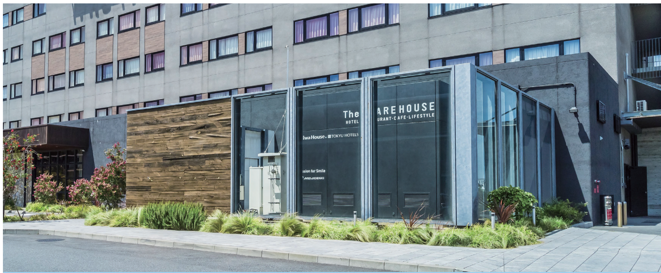
(写真上)レゾナックのプラスチックケミカルリサイクルプラント(水素等を製造)、(写真下)川崎キングスカイフロント東急REIホテルの純水素型燃料電池
