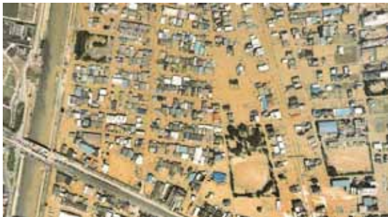
被災地の状況（名古屋市西区あし原町の破堤地付近） 平成12年9月13日 庄内川工事事務所撮影（国土地理院 提供）
