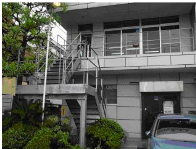
(新設した外部階段)
