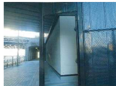
幸区堀川町跨道橋下備蓄倉庫 (平成28年6月供用開始)
