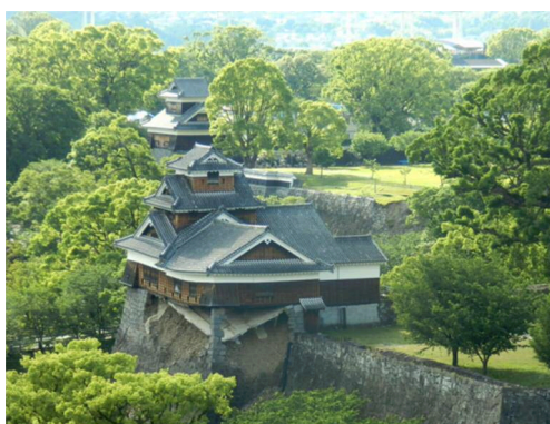
（熊本城飯田丸五階櫓石垣崩落の様子）
