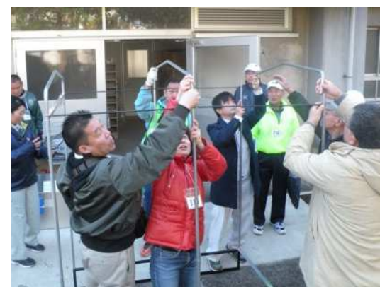
⑥ポール上部をアーム(両端が円になっているもの)でつなぎ、天井桟を3本差し込む。
