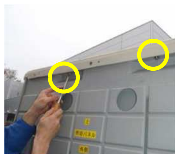
⑮天井パネルは外側もネジ留めをする。
