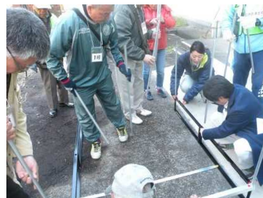
④架台とアングルの赤シール部分の穴を合わせ、その上からポールを差し込む(ポールは先が細い方を上向きにする)。
