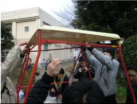
③天蓋の「前」シール方向を入口側に向けて支柱に差し込む。
