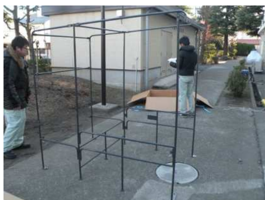
④骨組みの完成
