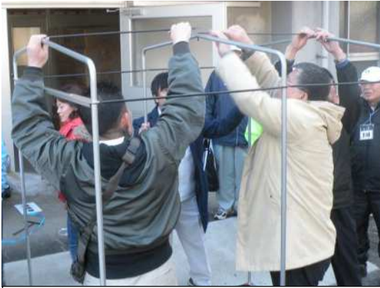
⑦両端と片端がフック型になっているアームを、天井枠の中央上につなげるように差し込む。
