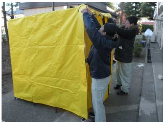
⑨出入口シートをフレームのカーテンリングに掛ける。
