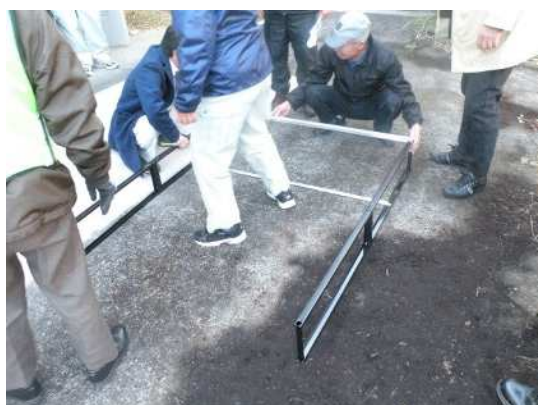
③袖金具の黄色シールにフラットバーを置く。
