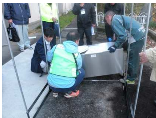
⑤正面シールが手前になるように、便槽外箱をフラットバーの上に乘せるように枠内にセットする。
