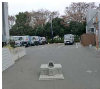
①床板を置く。
