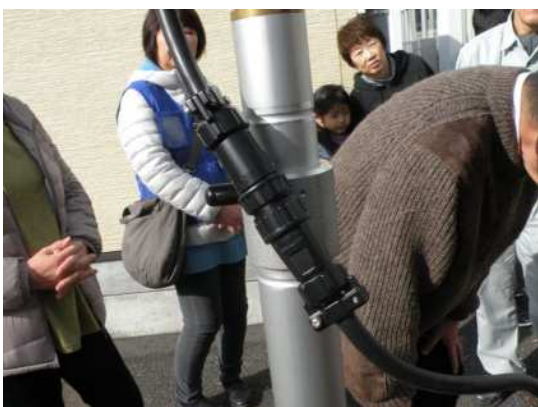
③照明器のコネクターを接続する。
