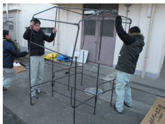
③上部フレームを下部フレームに差し込む。
