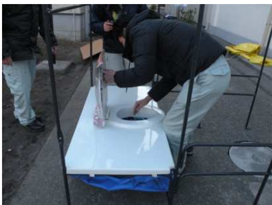
⑦床板をガタつきのないようにフレームに取り付ける。
