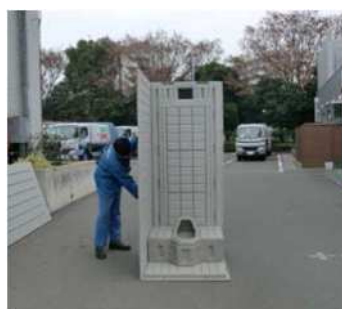
⑤側面パネルを立てる。
