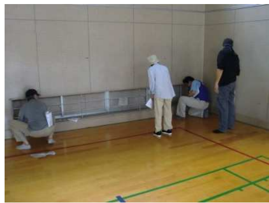
コードの敷設
