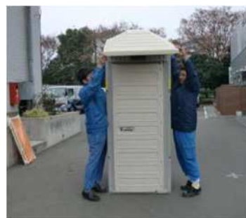
⑫側面パネルに天井パネルを取り付ける。
