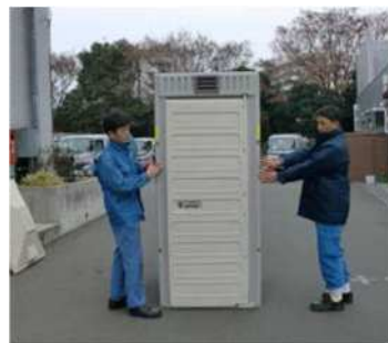
⑨扉パネルを立てる。
