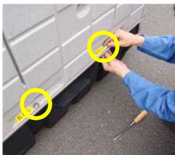
⑳側面パネルとタンクを長ネジで留める。
