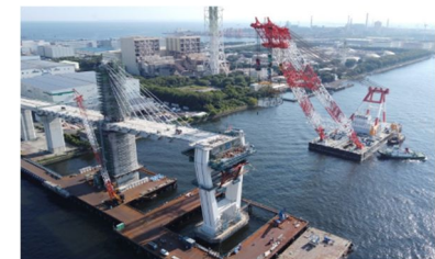
臨港道路東扇島水江町線の整備
