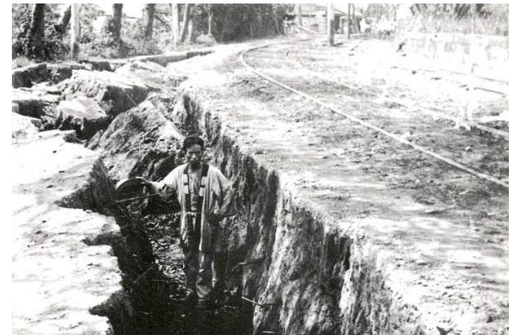
(写真) 大正関東大震災時の川崎 (地割れた市内地域)
