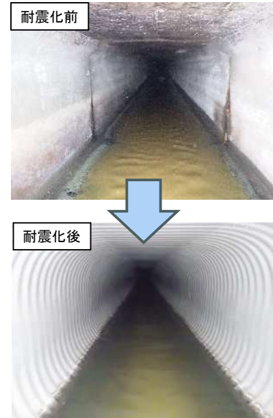
重点事業No.37関係 下水道の管きょ施設の耐震化
