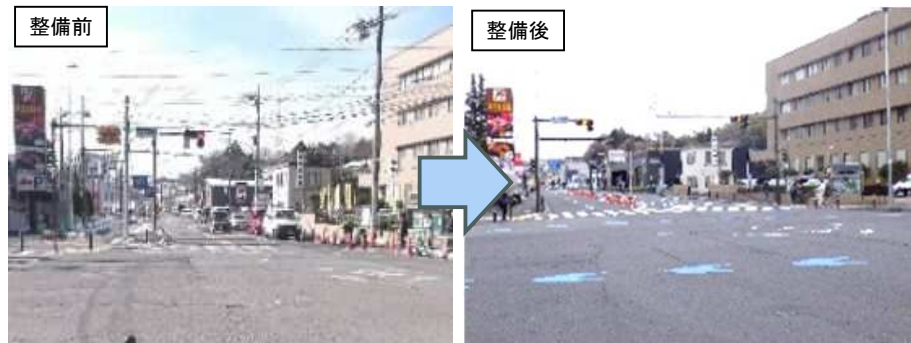
重点事業No.7関係 緊急輸送道路等の無電柱化の推進
