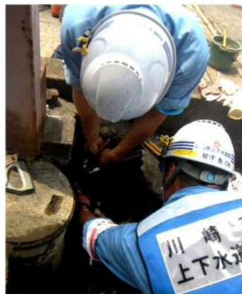
漏水している水道管(給水管)の修繕の様子
