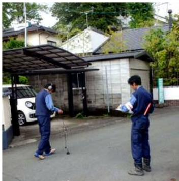
漏水探知機を用いた漏水調査の様子
