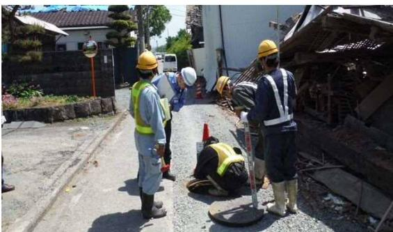
マンホールの内部が壊れていないか、下水の流れに支障がないかなどの調査を行っている様子
