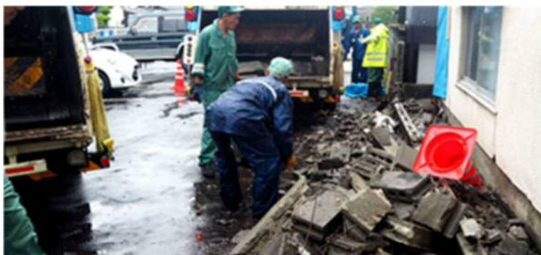
倒壊したブロック塀の撤去作業の様子
