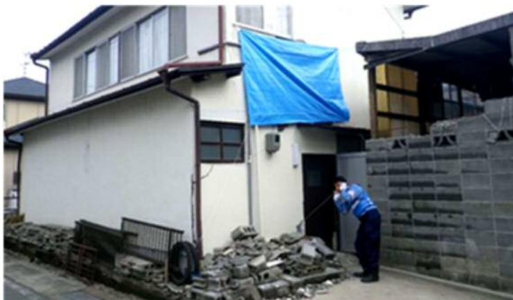
漏水探知機漏水調査器具「音聴棒」を使用した漏水調査の様子
