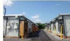
庇や縁側の設置
