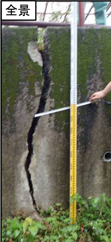
擁壁上部の宅地
