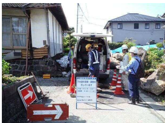
TV カメラによる管きょ内調査
