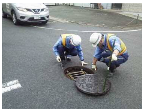
マンホール内状況確認
