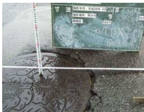
マンホールの変位量の計測②
