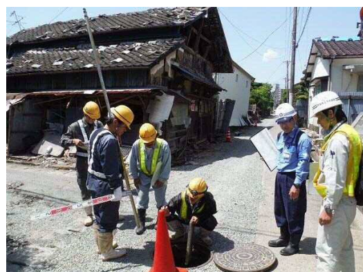
マンホールの調査
