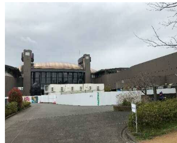
施設前広場の仮囲い
