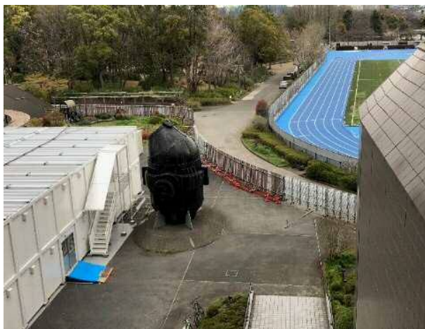
施設前広場の仮囲い（上部から撮影）
