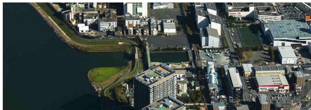
河港水門航空写真
