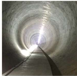
五反田川放水路
