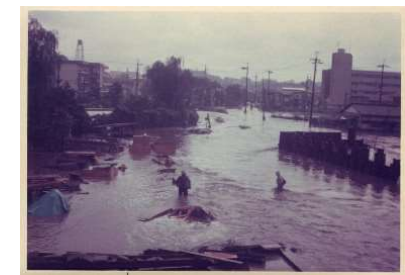
平瀬川の氾濫(高津区上作延/昭和51年)
