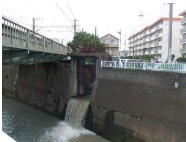
大丸用水接続部の水門
