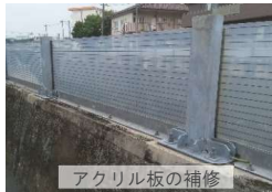
アクリル板の補修
