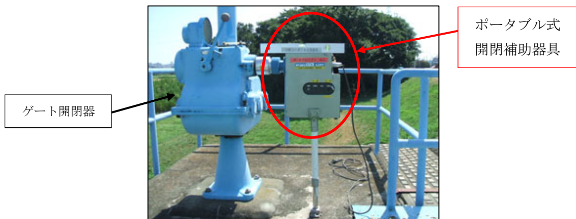
図 12-4-2 開閉補助器具使用のイメージ
